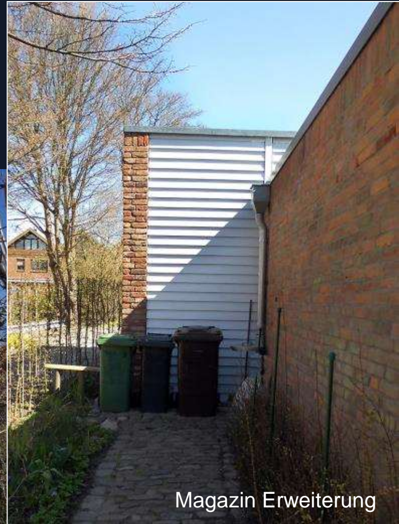
Erweiterungsbau der Halle
